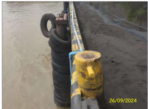
ติดตั้งหลักผูกเรือ และยางกันกระแทกเรือบริเวณท่าเรือ
